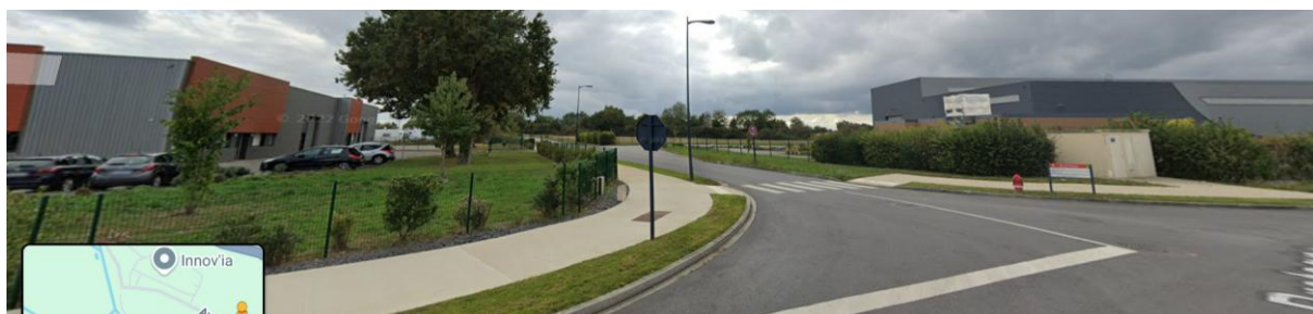
Exemple de traitement espace public au sein de la tranche 1 de l'AA du Segréen (carrefour avenue de Bretagne et rue de l'Echelette)
