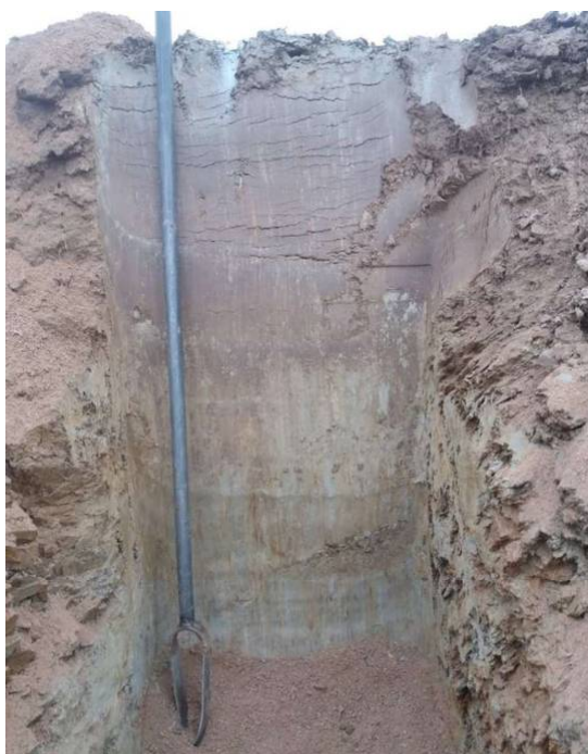
Tranchée sur le secteur 2 en cours d'aménagement
